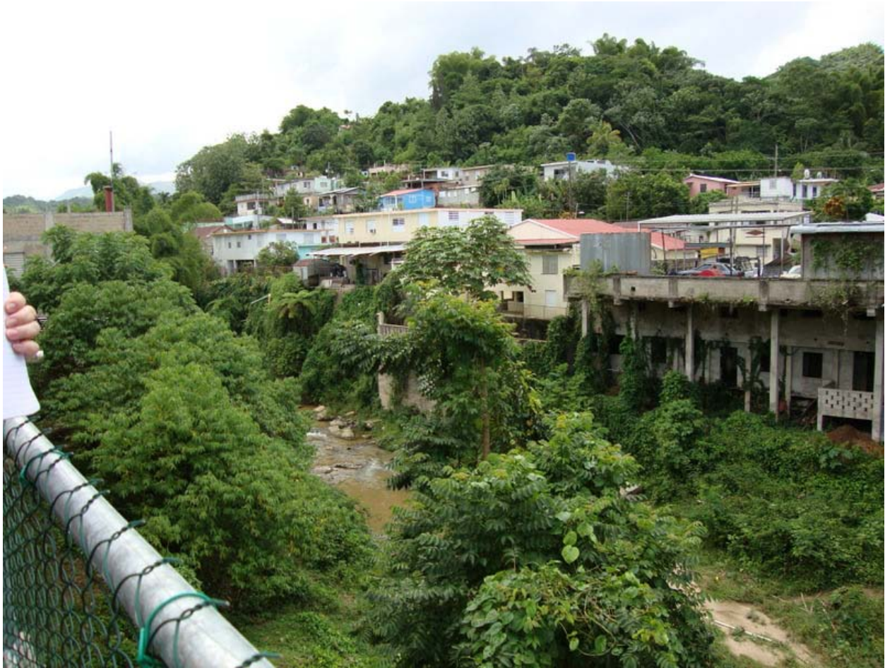
Vista al sur desde los balcones del establecimiento en el lado suroeste del edificio
