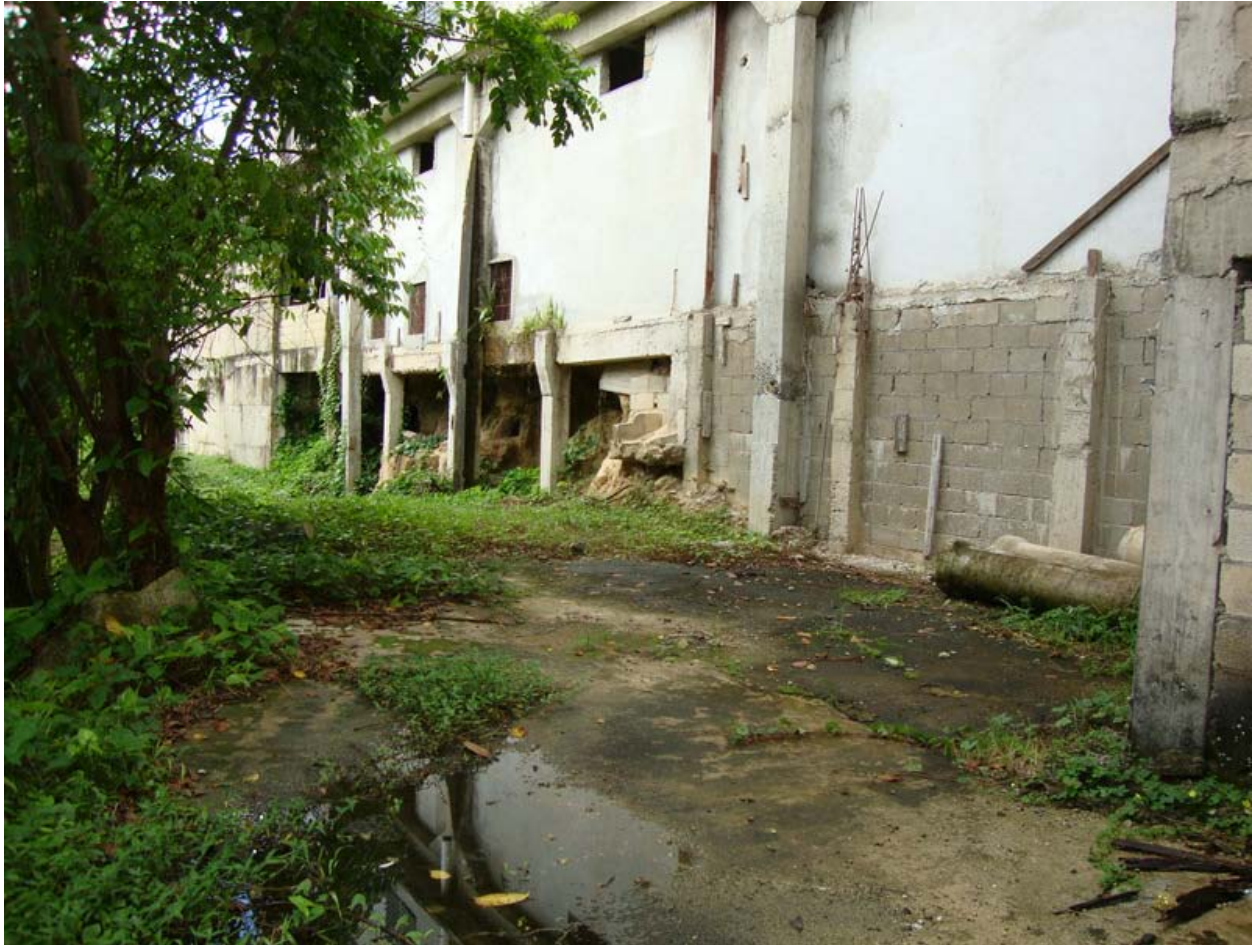
Pared suroeste del edificio de la PPI frente al río Viví
